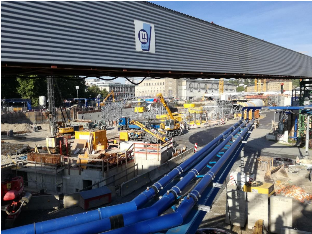
Abbildung 2: Blick auf das Baufeld bei Messende am 10.09.2018
