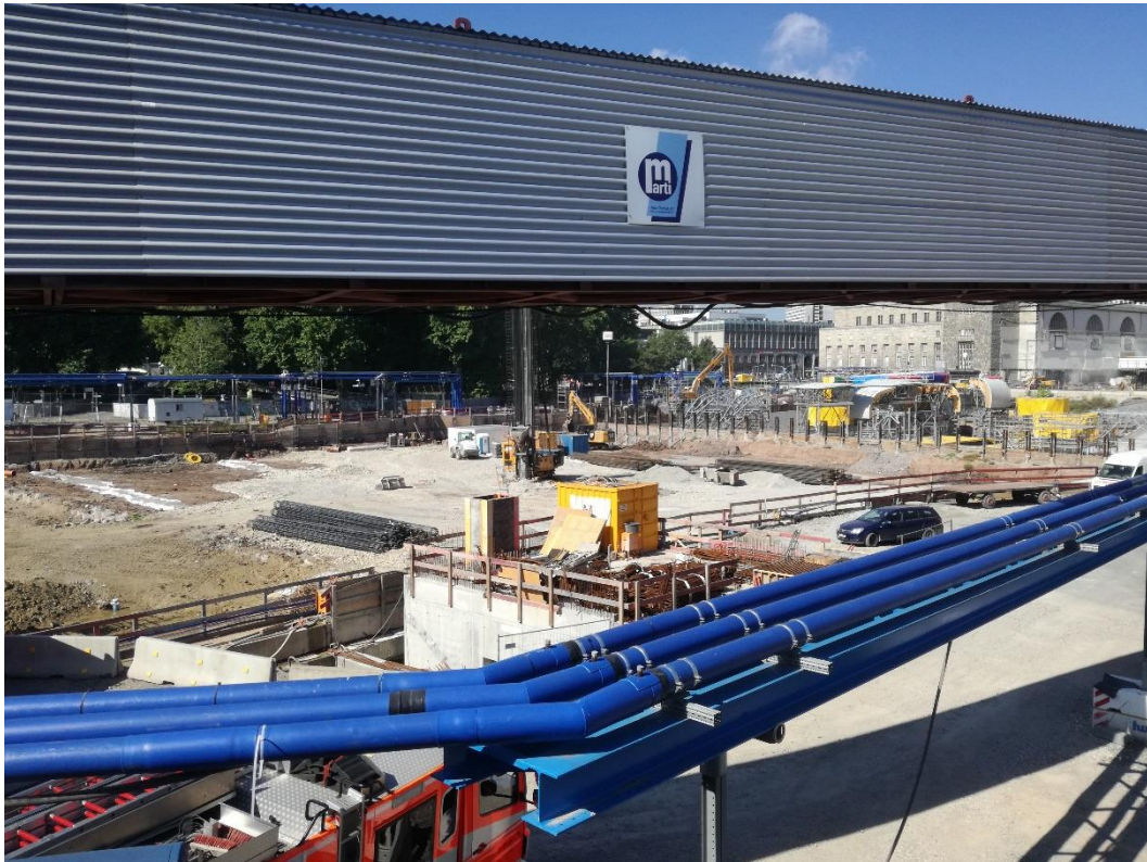
Abbildung 2: Blick auf das Baufeld bei Messende am 30.07.2018
