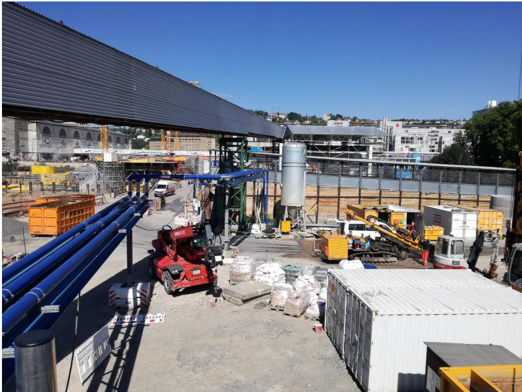
Abbildung 2: Blick auf das Baufeld bei Messende am 09.07.2018
