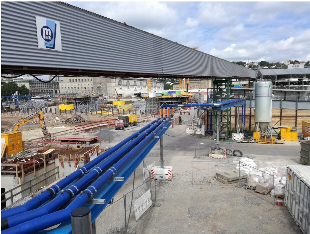
Abbildung 2: Blick auf das Baufeld bei Messende am 18.06.2018
