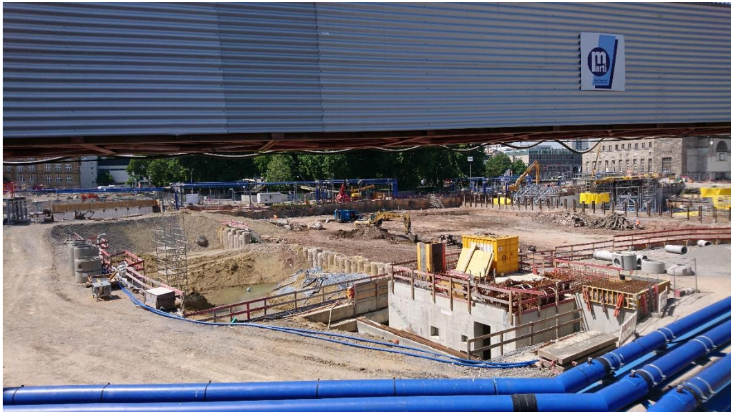
Abbildung 2: Blick auf das Baufeld bei Messende am 28.05.2018
