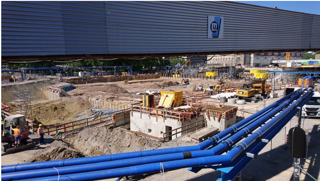
Abbildung 2: Blick auf das Baufeld bei Messende am 07.05.2018
