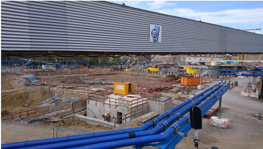
Abbildung 2: Blick auf das Baufeld bei Messende am 16.04.2018
