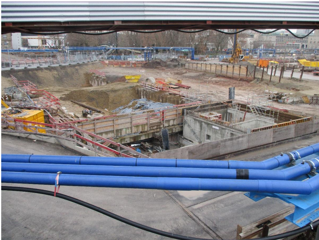
Abbildung 2: Blick auf das Baufeld bei Messende am 21.12.2017
