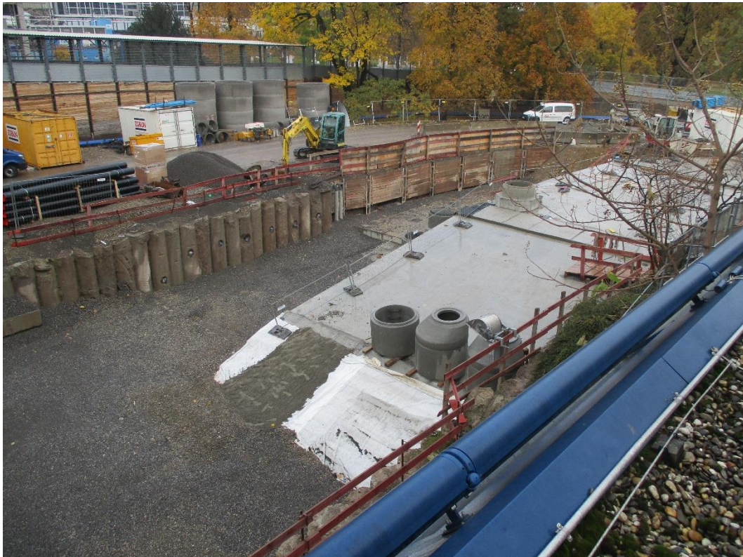
Abbildung 2: Blick auf das Baufeld bei Messende am 13.11.2017
