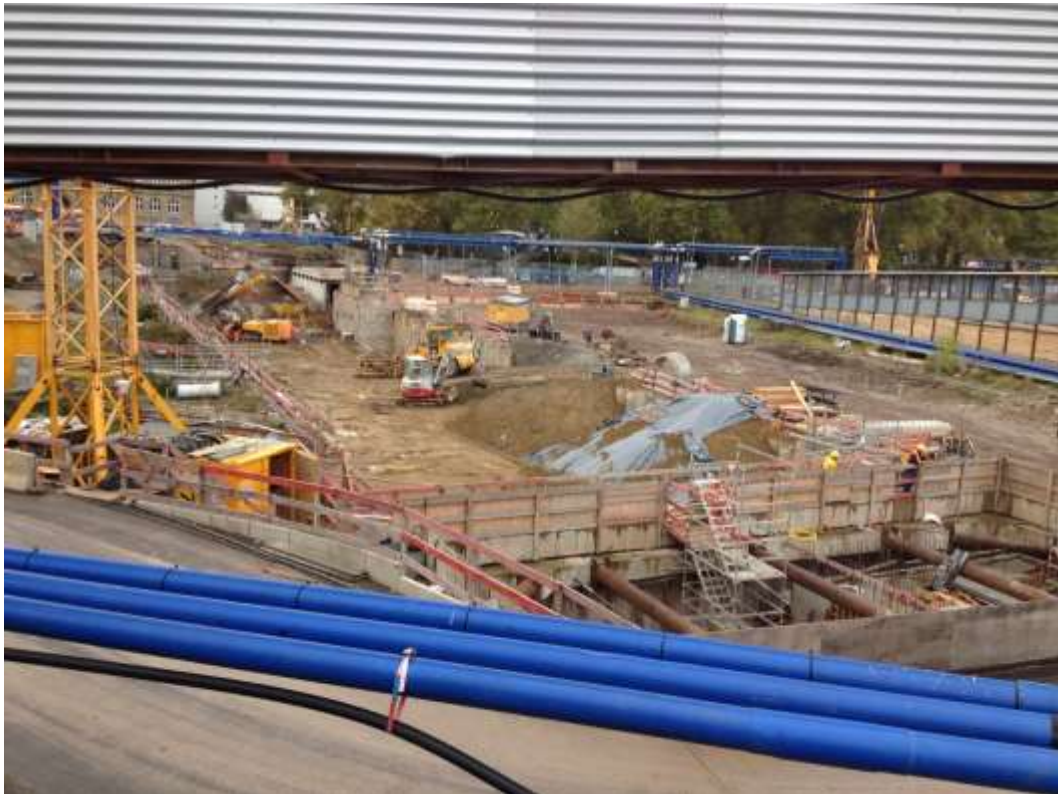
Abbildung 2: Blick auf das Baufeld bei Messende am 23.10.2017
