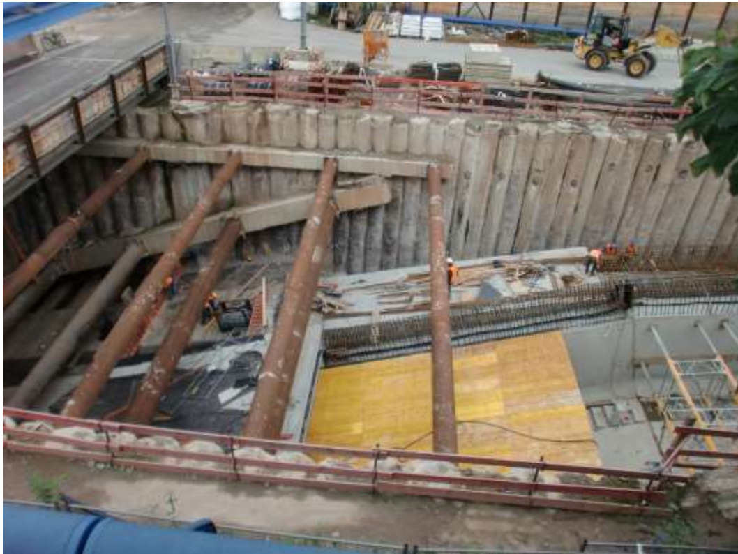
Abbildung 2: Blick auf das Baufeld bei Messende am 11.09.2017
