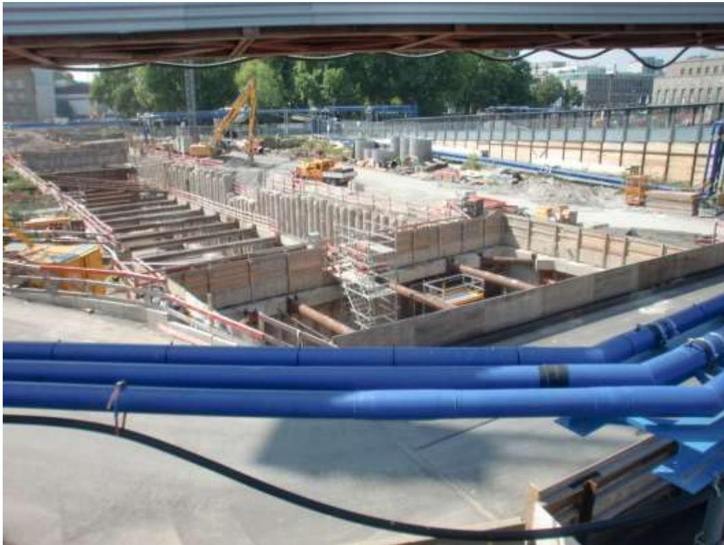
Abbildung 2: Blick auf das Baufeld bei Messende am 28.08.2017
