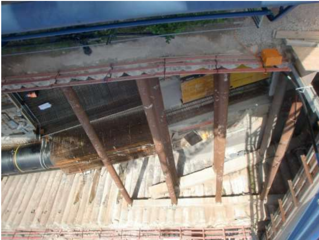
Abbildung 2: Blick auf das Baufeld bei Messende am 31.07.2017
