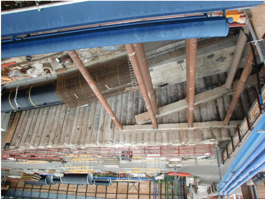
Abbildung 2: Blick auf das Baufeld bei Messende am 10.07.2017
