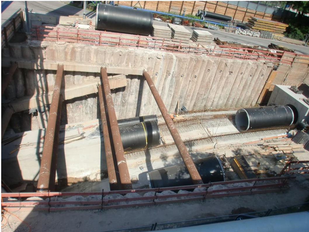
Abbildung 2: Blick auf das Baufeld bei Messende am 29.05.2017
