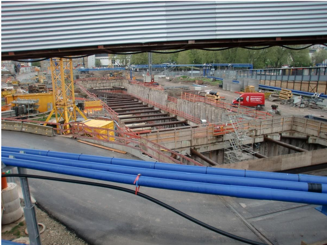
Abbildung 2: Blick auf das Baufeld bei Messende am 18.04.2017
