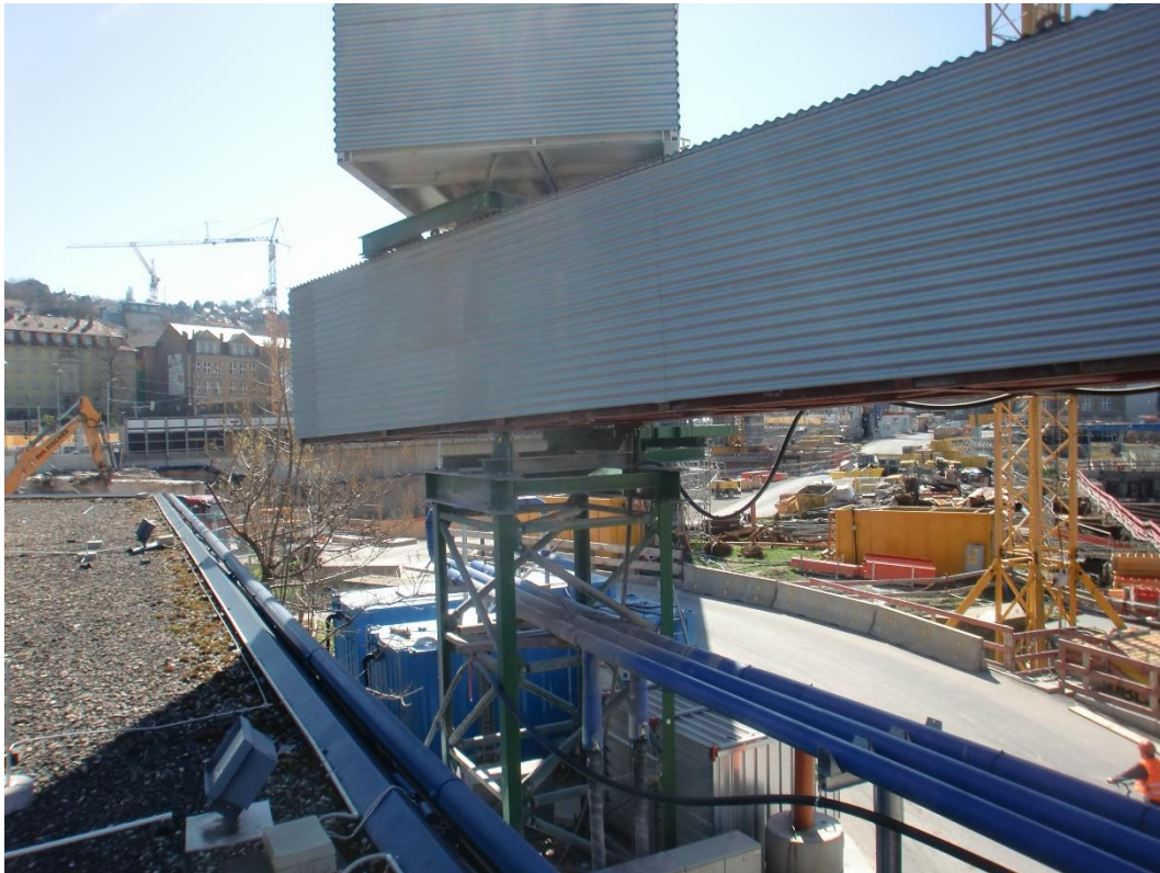
Abbildung 2: Blick auf das Baufeld bei Messende am 27.03.2017
