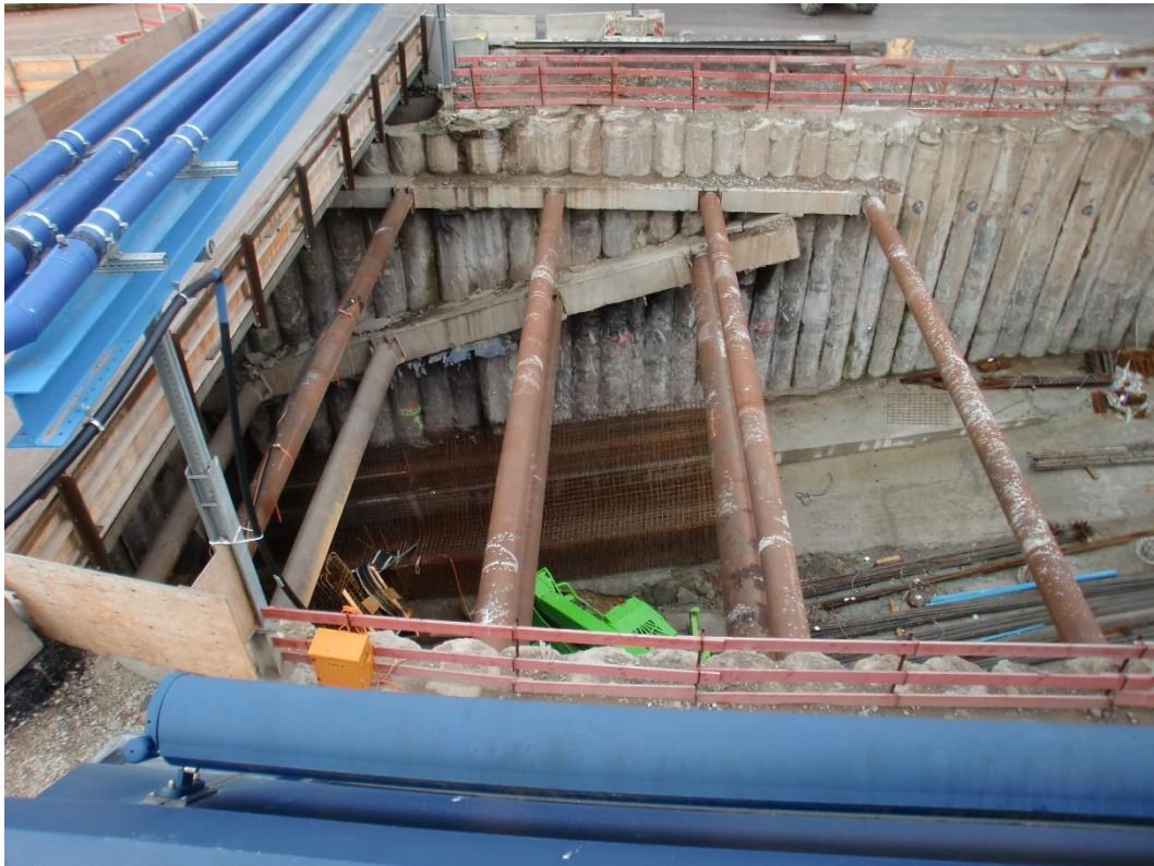
Abbildung 2: Blick auf das Baufeld bei Messende am 06.03.2017
