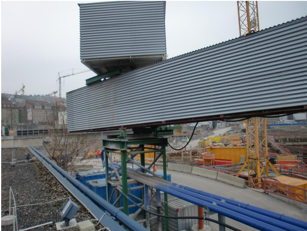
Abbildung 2: Blick auf das Baufeld bei Messende am 13.02.2017
