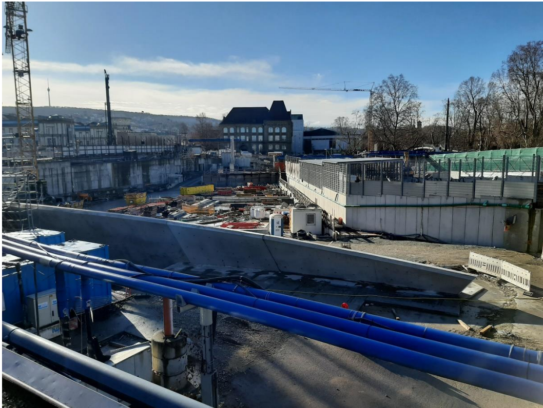
Abbildung 2: Blick auf das Baufeld bei Messende am 16.01.2023
