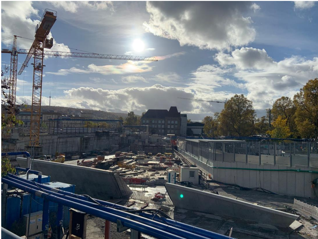
Abbildung 2: Blick auf das Baufeld bei Messende am 21.11.2022
