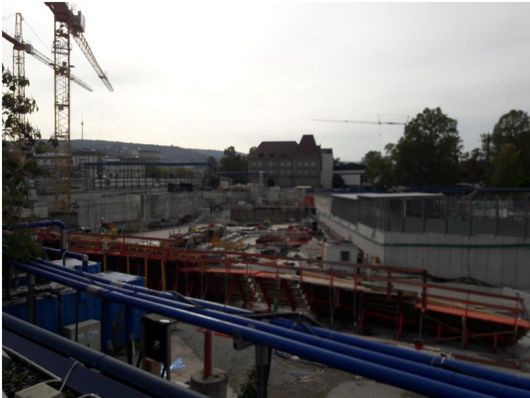
Abbildung 2: Blick auf das Baufeld bei Messende am 31.10.2022
