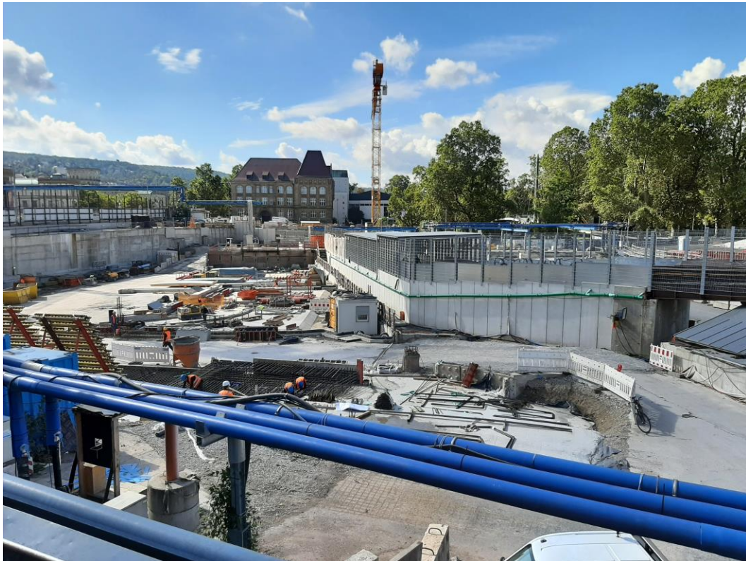
Abbildung 2: Blick auf das Baufeld bei Messende am 26.09.2022
