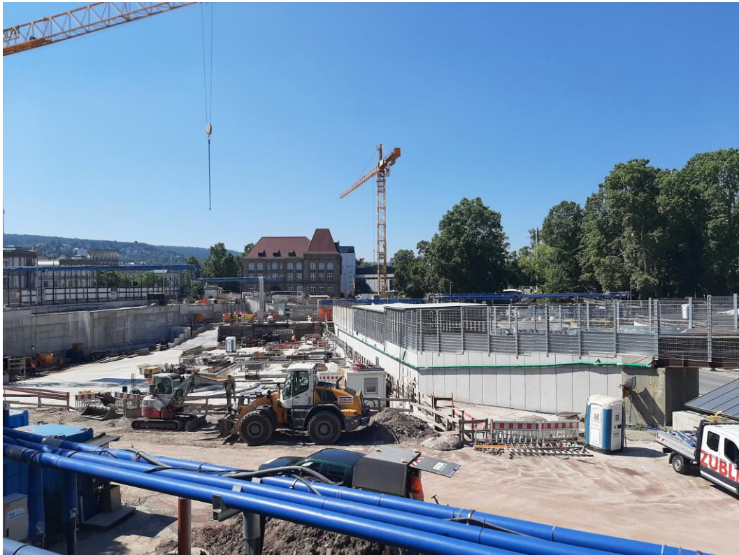
Abbildung 2: Blick auf das Baufeld bei Messende am 25.07.2022
