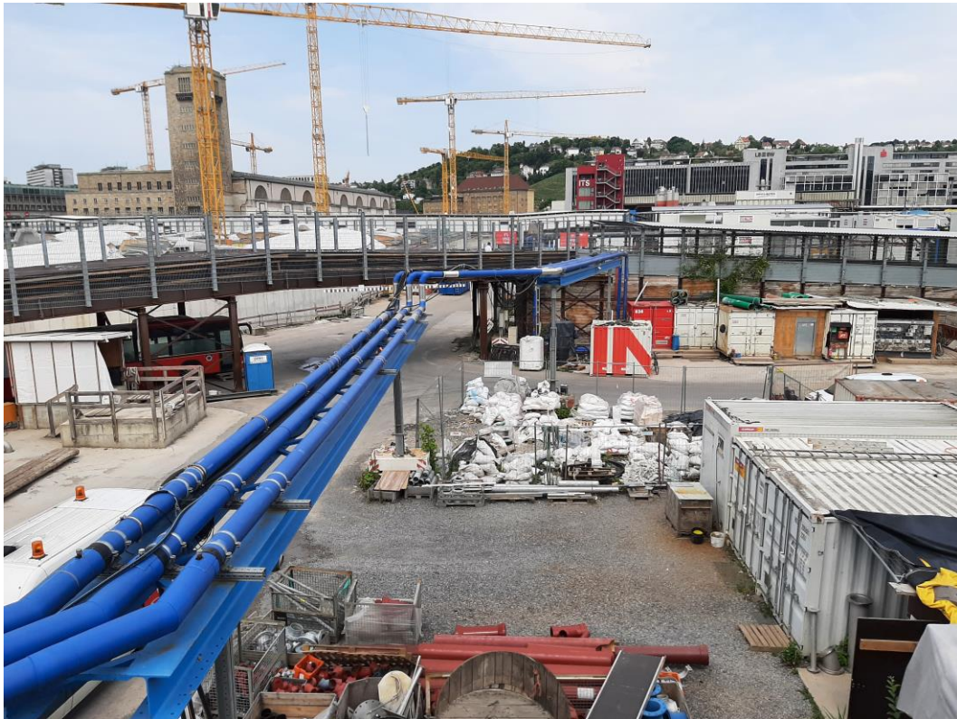
Abbildung 2: Blick auf das Baufeld bei Messende am 20.06.2022
