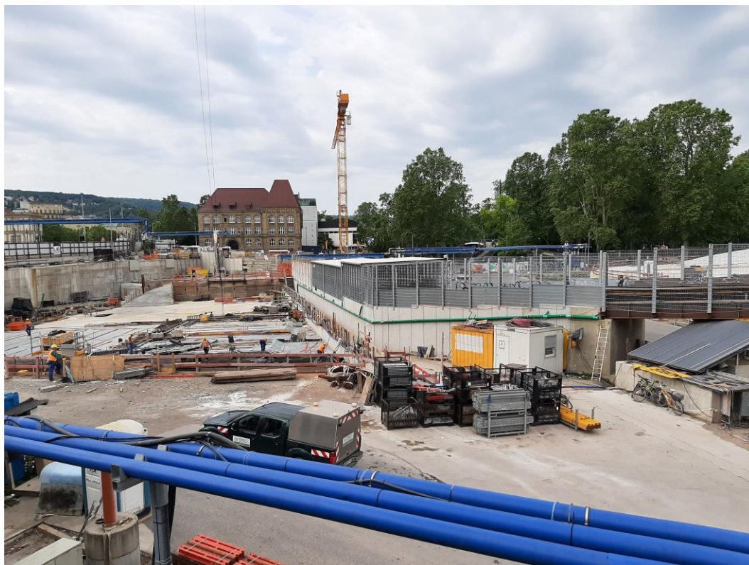
Abbildung 2: Blick auf das Baufeld bei Messende am 23.05.2022
