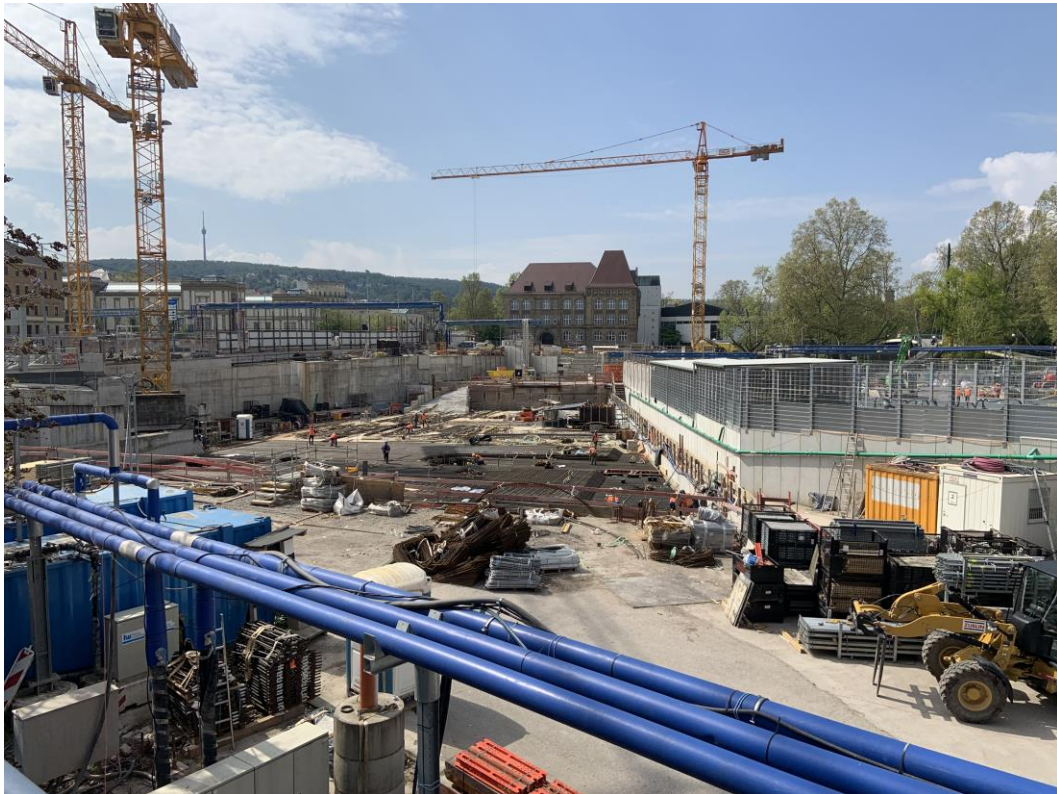
Abbildung 2: Blick auf das Baufeld bei Messende am 02.05.2022
