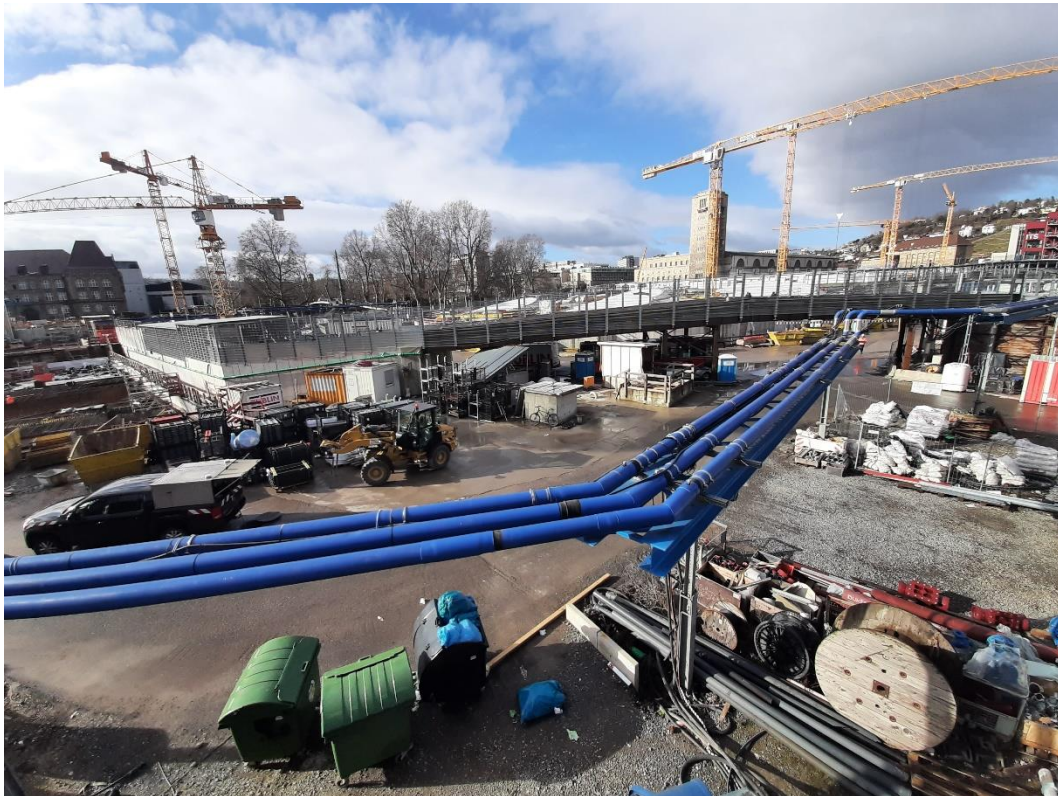
Abbildung 2: Blick auf das Baufeld bei Messende am 07.02.2021
