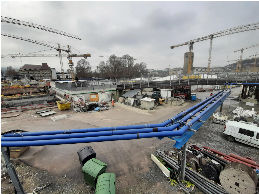
Abbildung 2: Blick auf das Baufeld bei Messende am 13.12.2021
