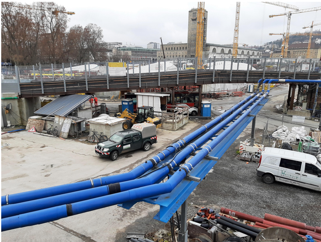
Abbildung 1: Blick auf das Baufeld bei Messbeginn am 06.12.2021
