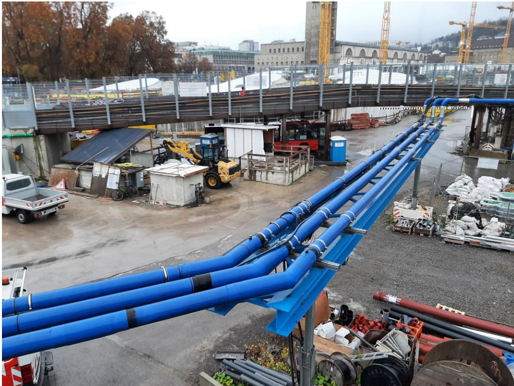
Abbildung 2: Blick auf das Baufeld bei Messende am 22.11.2021
