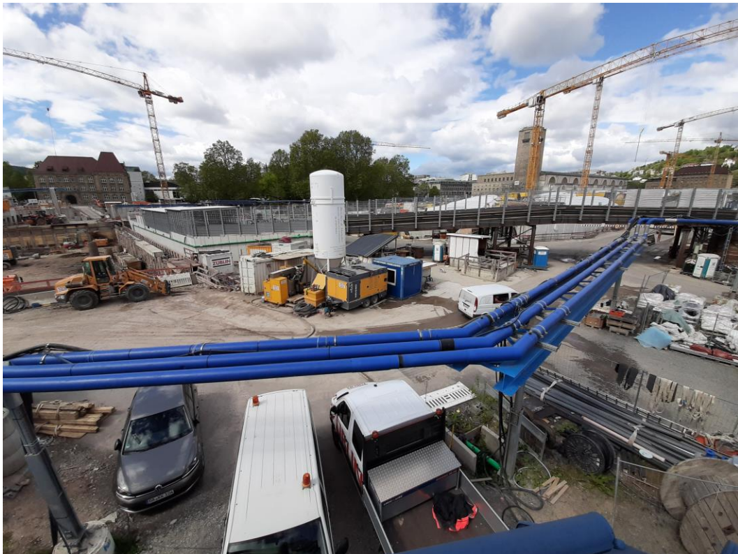
Abbildung 2: Blick auf das Baufeld bei Messende am 24.05.2021
