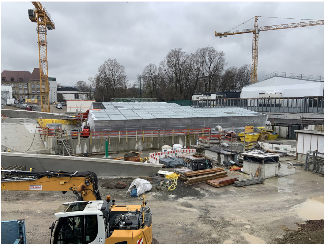
Abbildung 2: Blick auf das Baufeld bei Messende am 25.03.2024
