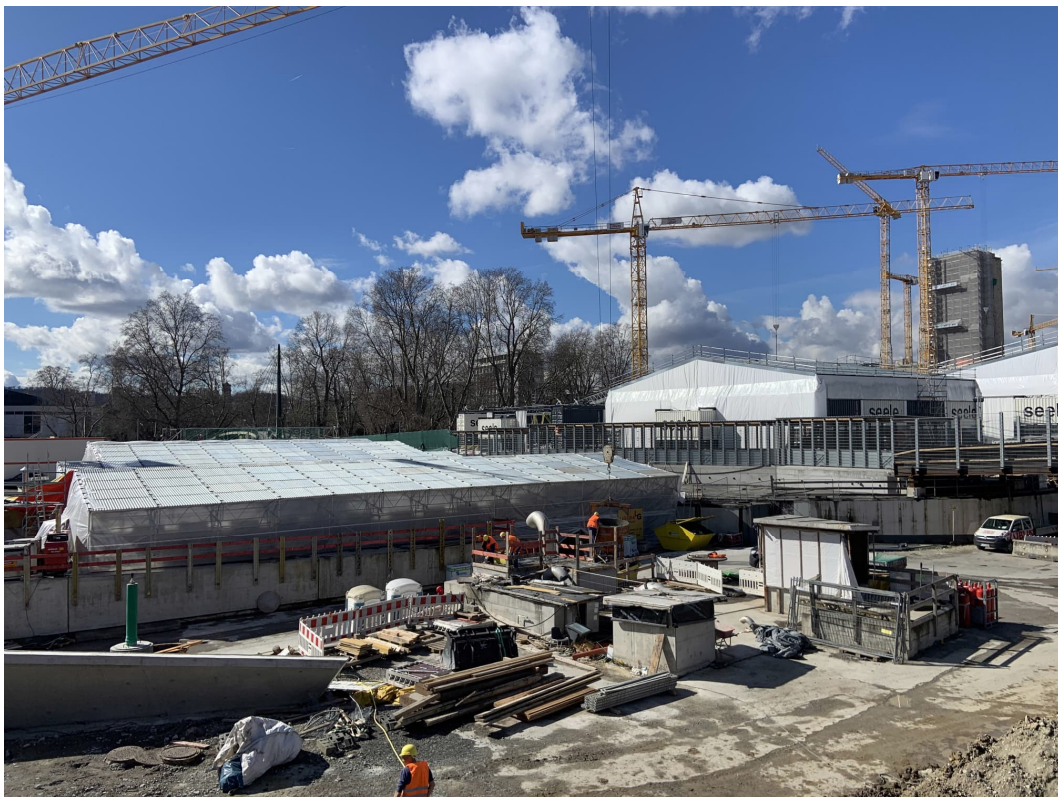
Abbildung 1: Blick auf das Baufeld bei Messbeginn am 18.03.2024
