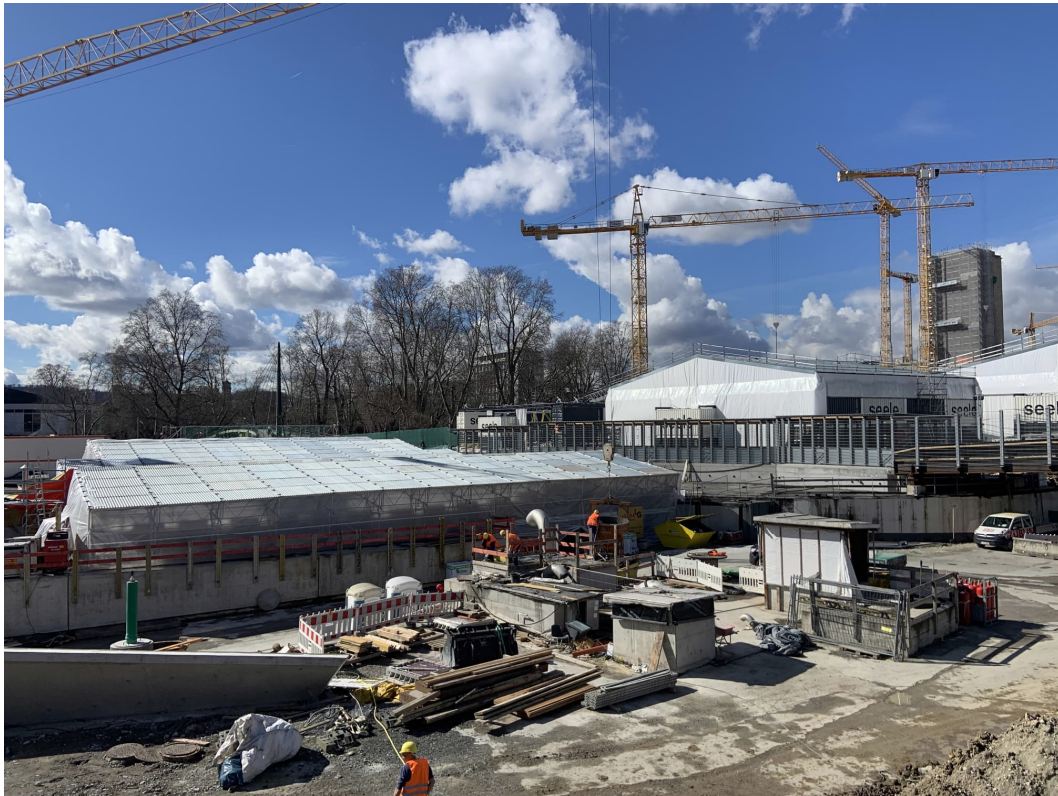
Abbildung 2: Blick auf das Baufeld bei Messende am 11.03.2024
