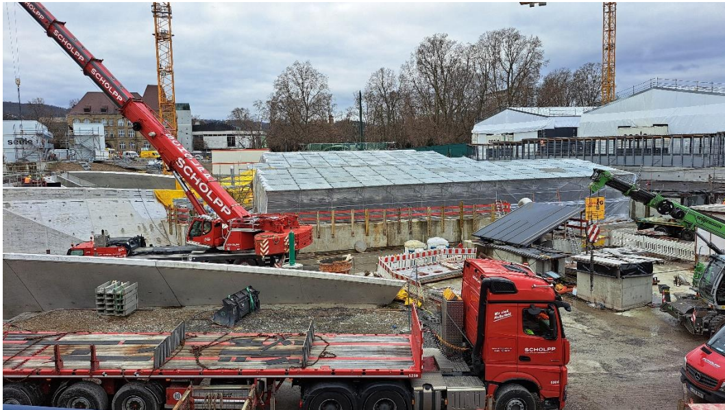
Abbildung 2: Blick auf das Baufeld bei Messende am 19.02.2024
