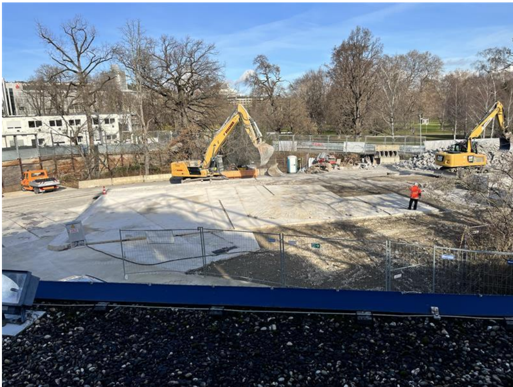
Abbildung 2: Blick auf das Baufeld bei Messende am 13.02.2024
