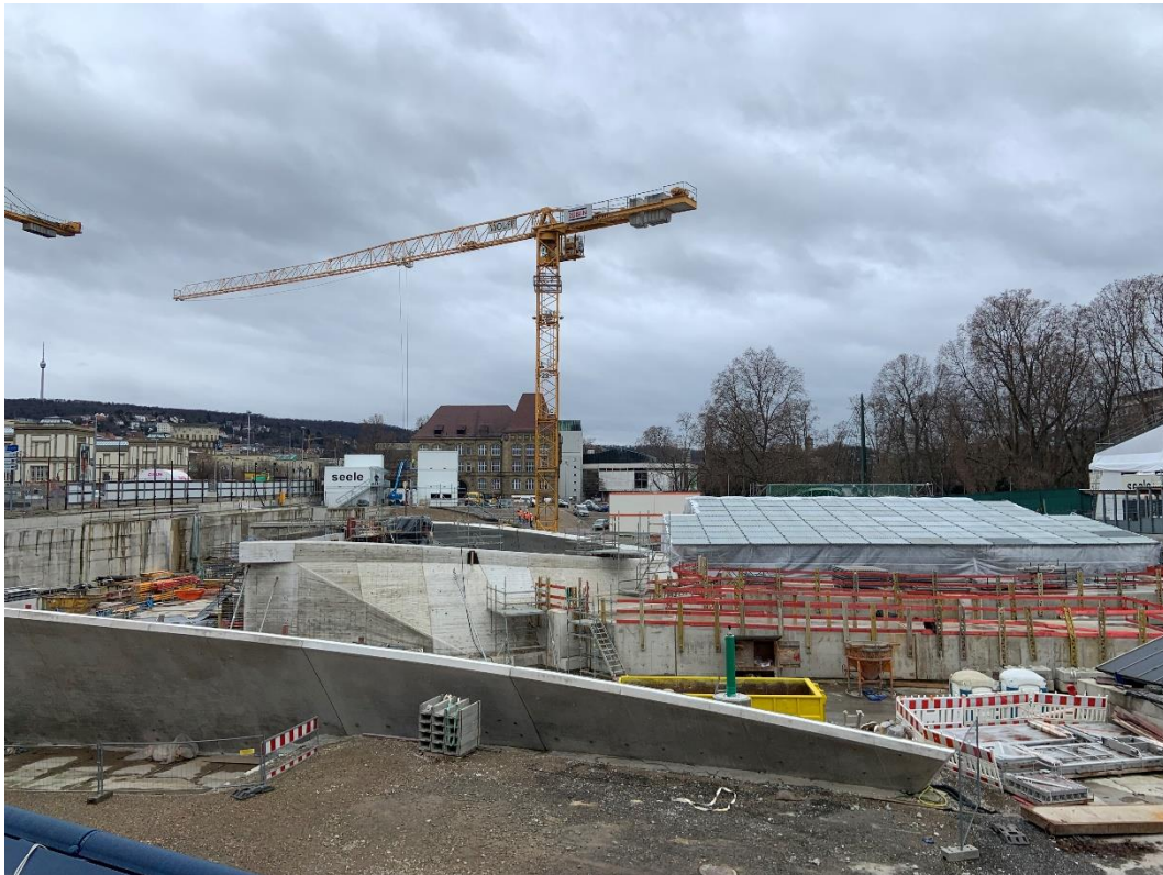
Abbildung 2: Blick auf das Baufeld bei Messende am 22.01.2024
