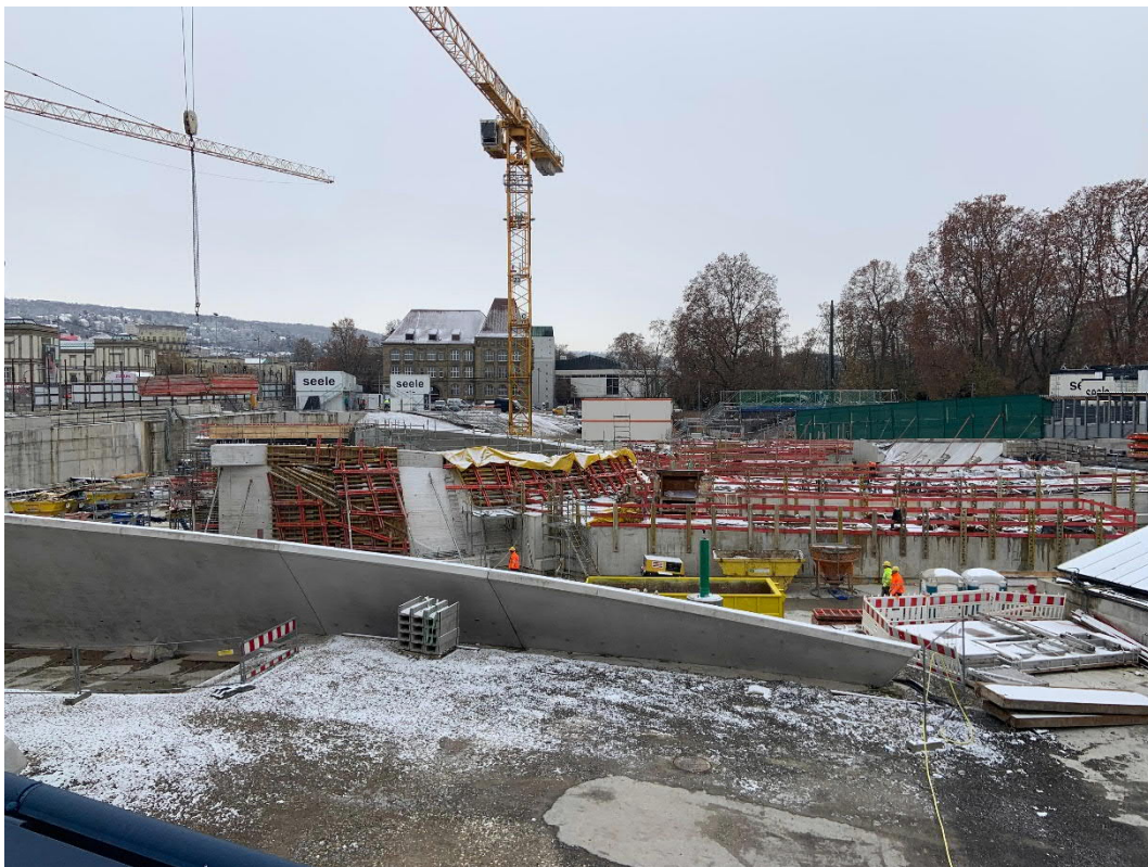
Abbildung 1: Blick auf das Baufeld bei Messbeginn am 04.12.2023
