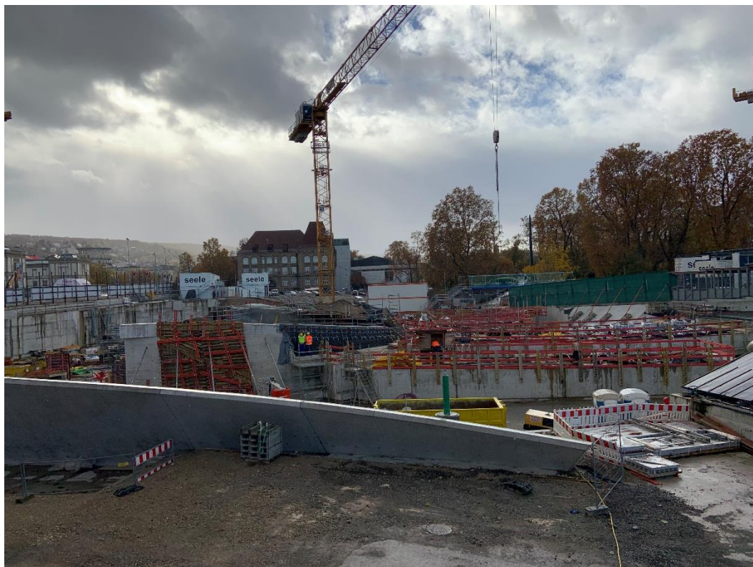
Abbildung 2: Blick auf das Baufeld bei Messende am 20.11.2023
