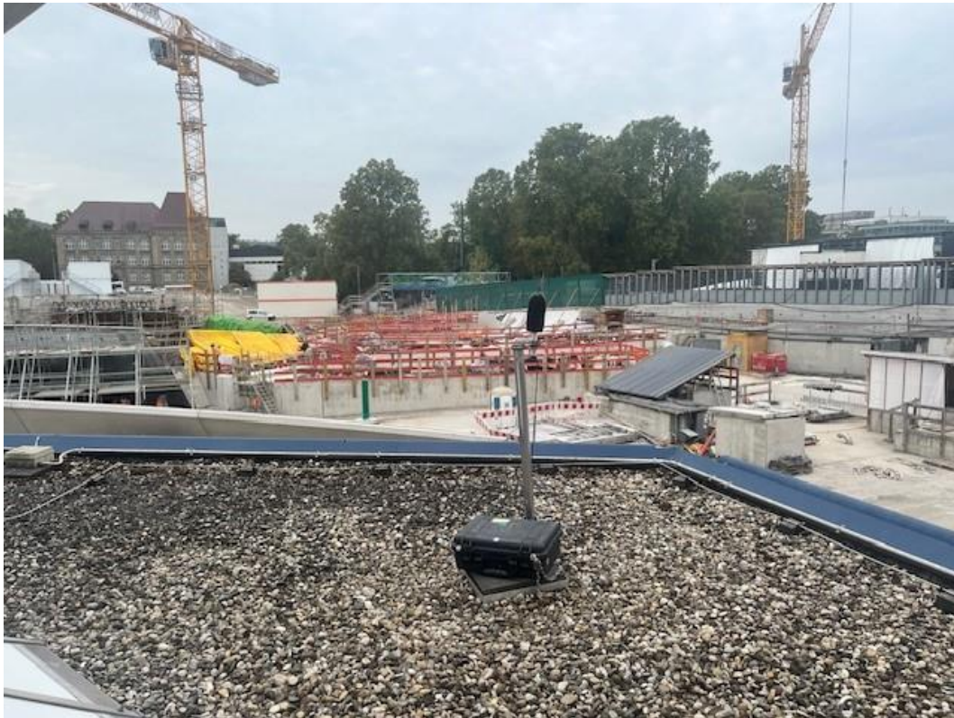
Abbildung 2: Blick auf das Baufeld bei Messende am 30.10.2023
