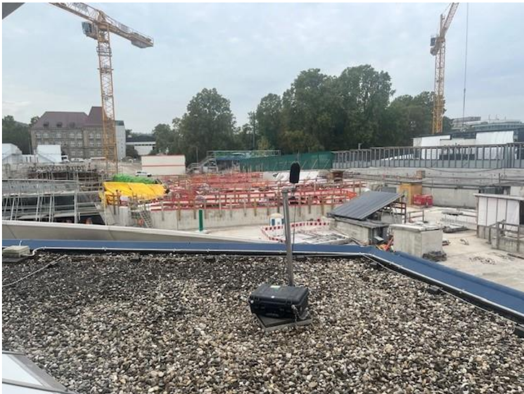
Abbildung 2: Blick auf das Baufeld bei Messende am 09.10.2023
