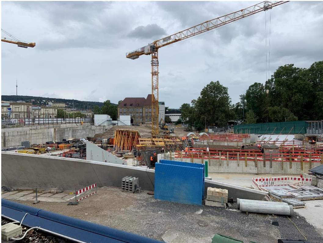
Abbildung 2: Blick auf das Baufeld bei Messende am 28.08.2023
