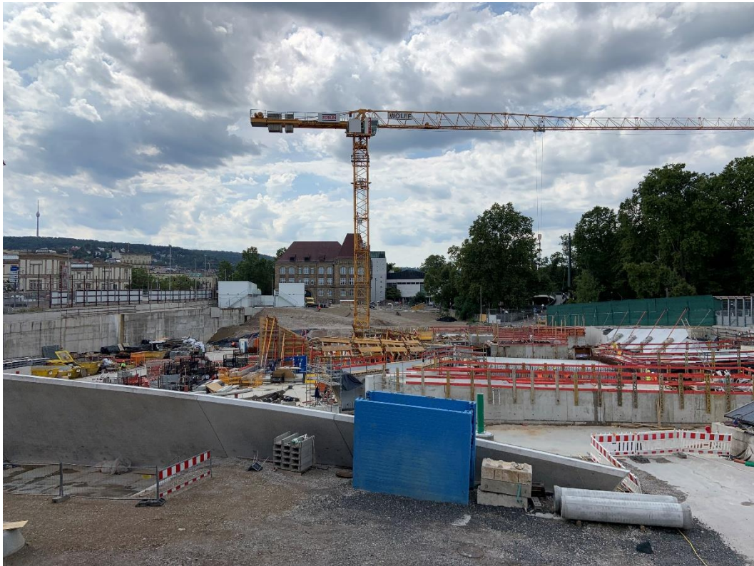
Abbildung 2: Blick auf das Baufeld bei Messende am 14.08.2023
