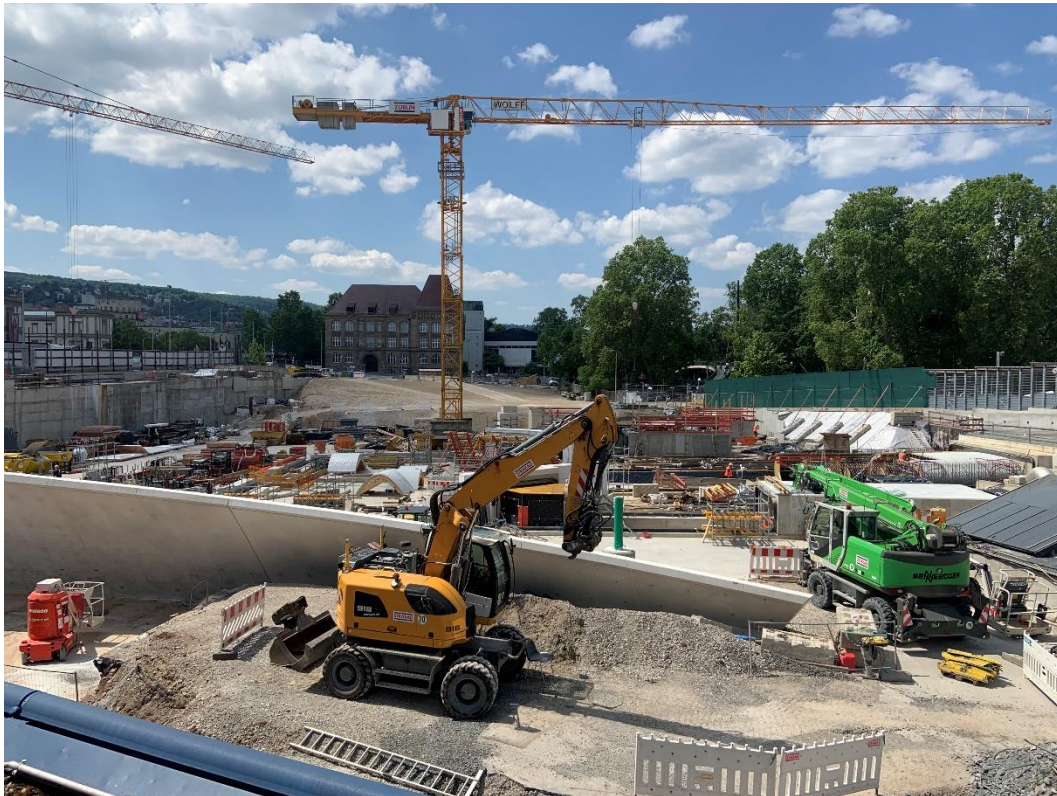
Abbildung 2: Blick auf das Baufeld bei Messende am 12.05.2023
