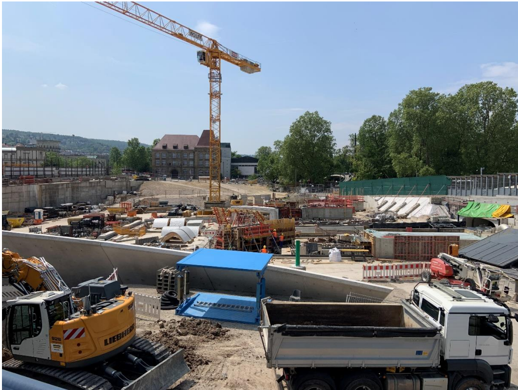
Abbildung 2: Blick auf das Baufeld bei Messende am 22.05.2023
