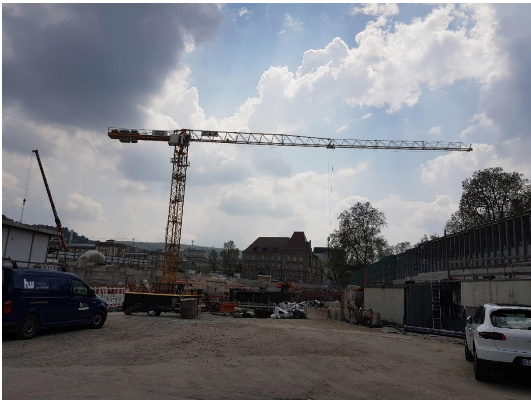
Abbildung 1: Blick auf das Baufeld bei Messbeginn am 02.05.2023
