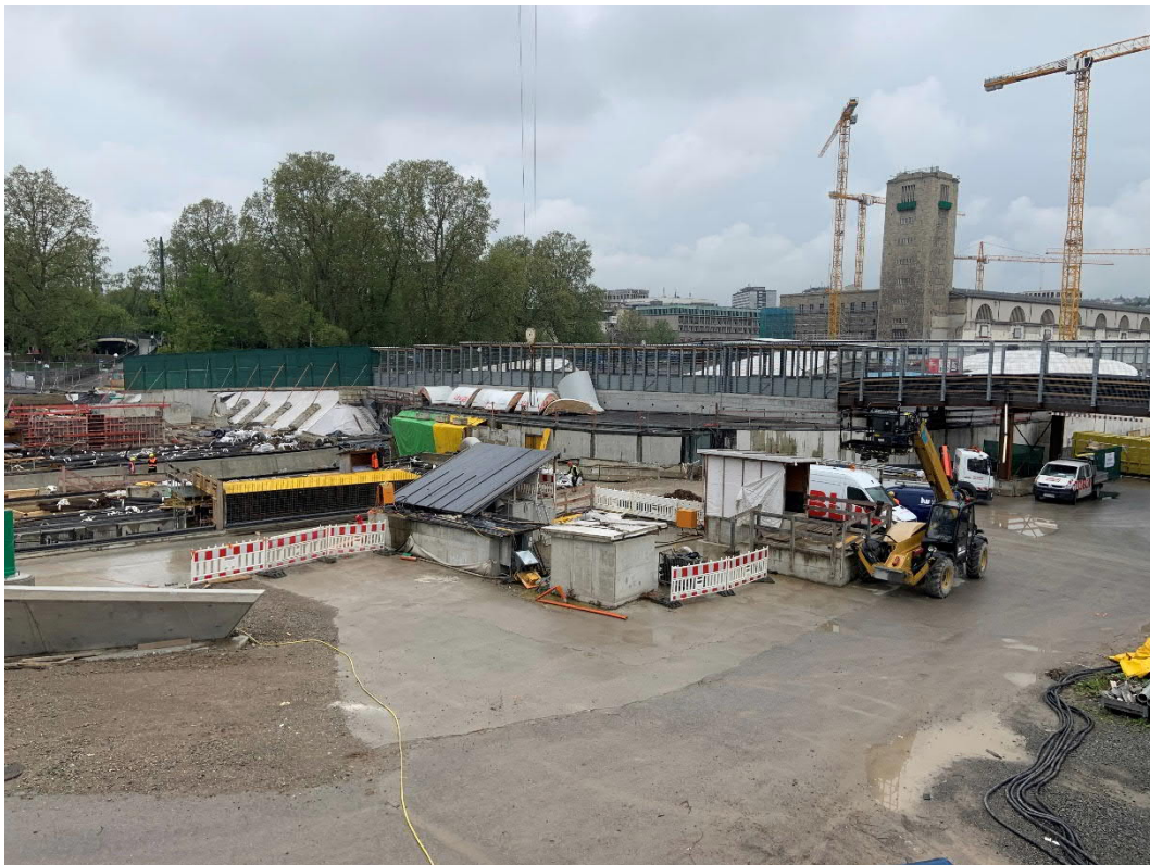
Abbildung 2: Blick auf das Baufeld bei Messende am 08.05.2023
