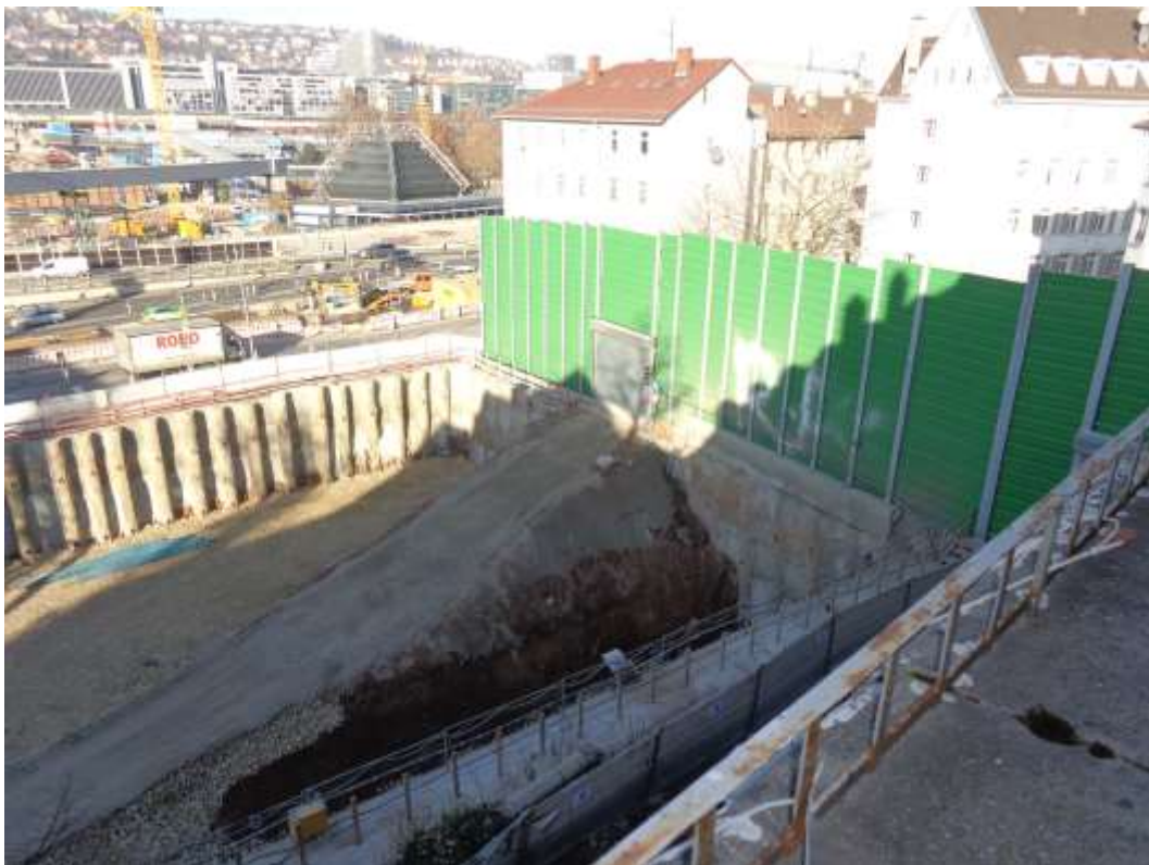
Abbildung 1: Blick auf das Baufeld bei Messbeginn am 01.12.2016
