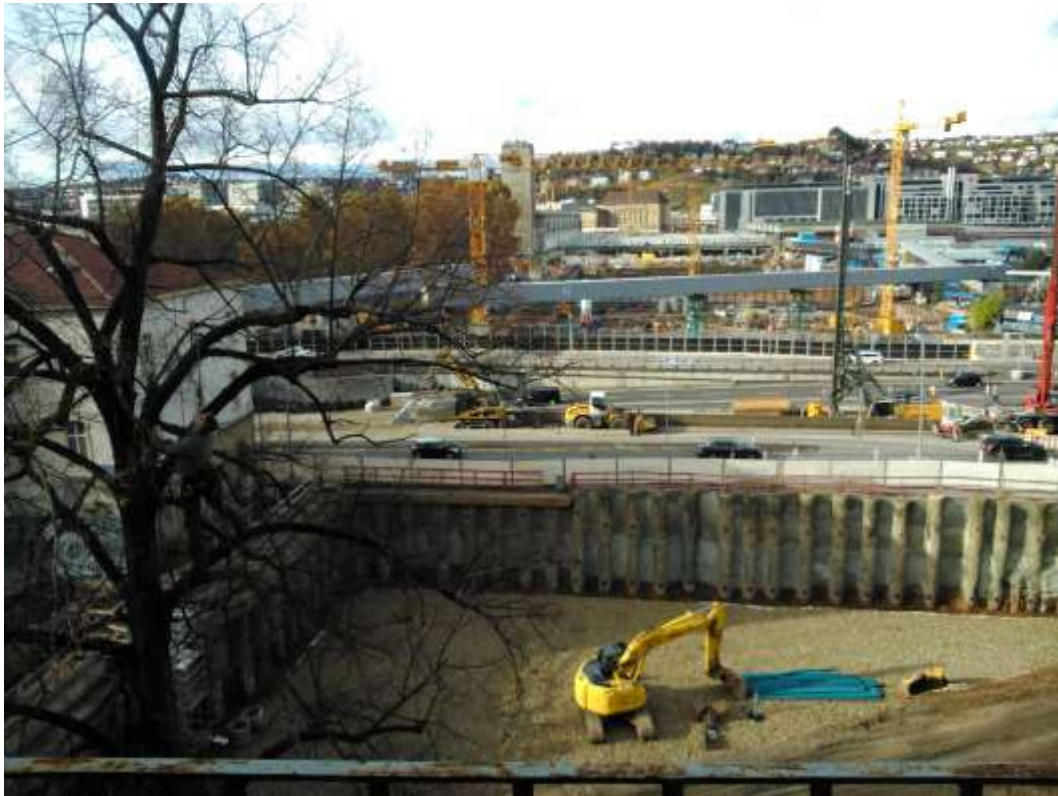
Abbildung 2: Blick auf das Baufeld bei Messende am 17.11.2016
