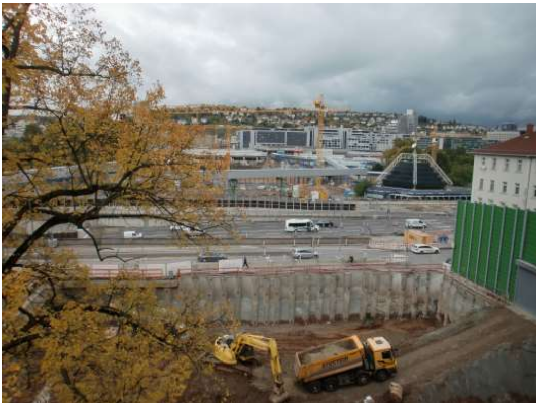
Abbildung 1: Blick auf das Baufeld bei Messbeginn am 20.10.2016
