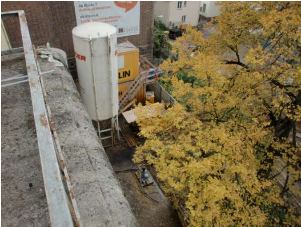
Abbildung 2: Blick auf das Baufeld bei Messende am 27.10.2016
