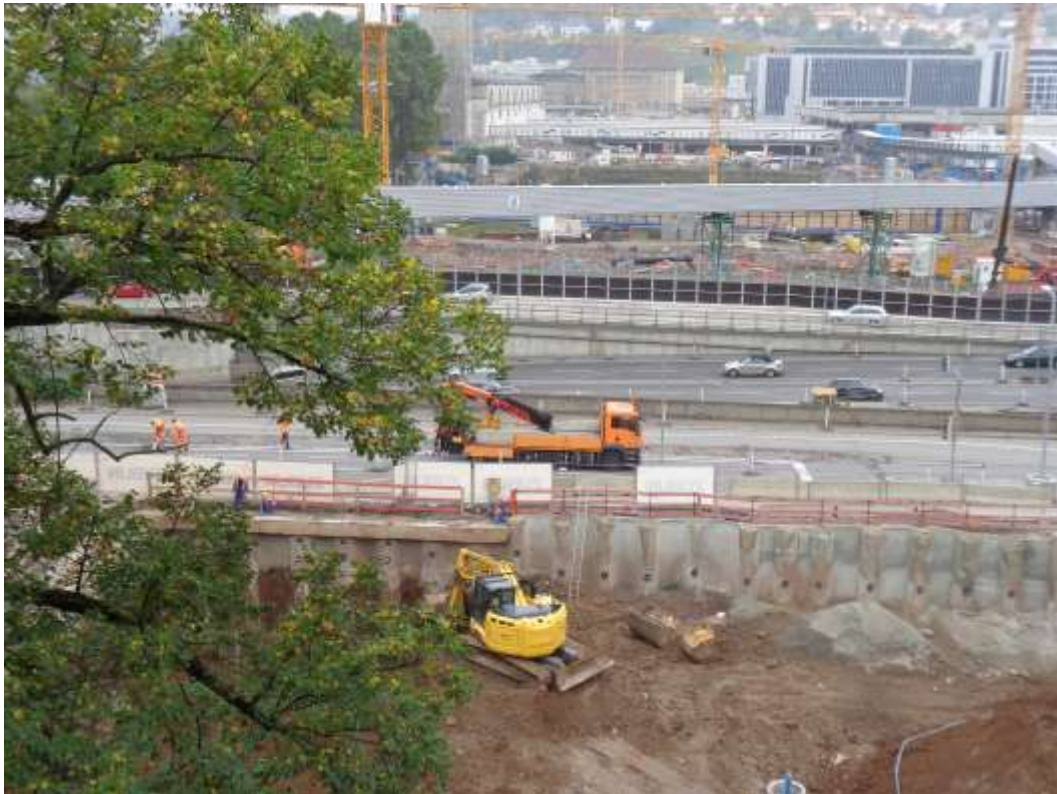
Abbildung 2: Blick auf das Baufeld bei Messende am 04.10.2016
