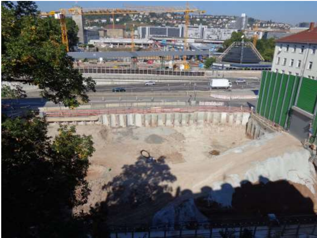
Abbildung 2: Blick auf das Baufeld bei Messende am 12.09.2016
